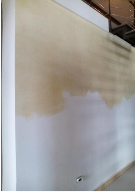
Recupero per il settore della bio-edilizia. Pitturazione locali della "GB agricola, la casa della cipolla ramata di Montoro", Montoro (AV)
